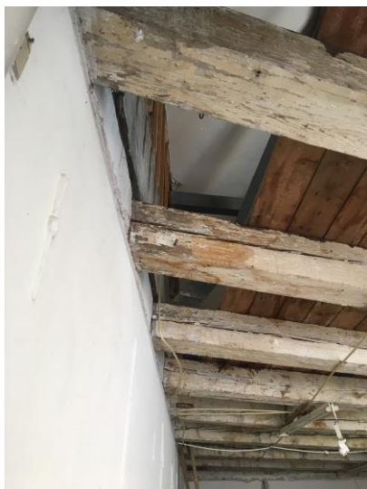
Repareren houtconstructie met giethars
