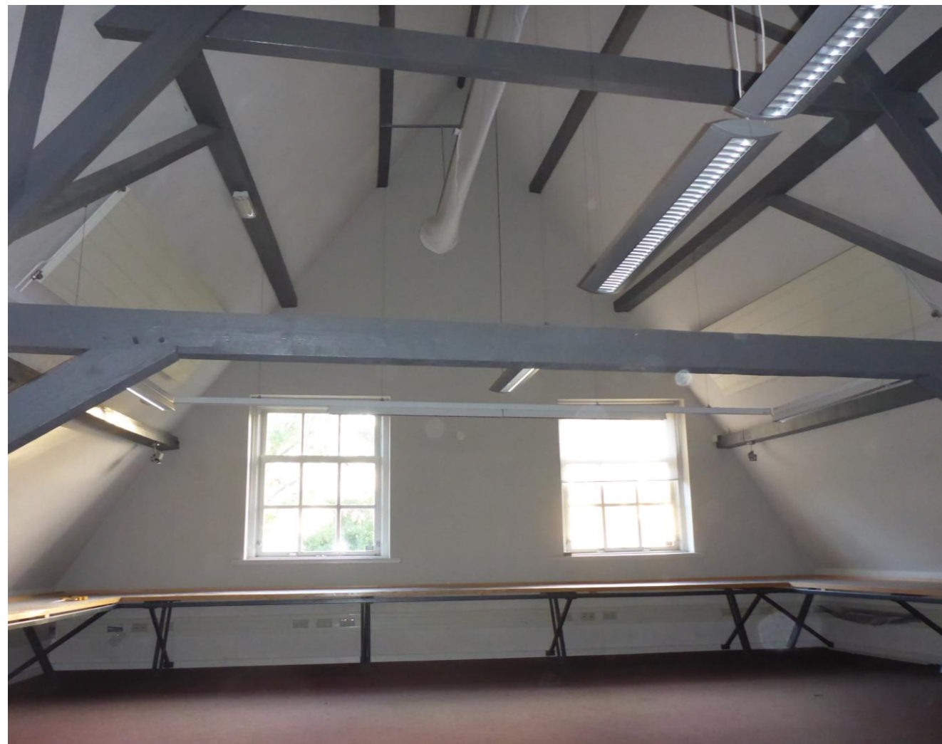
Plaatsing voorzetwand met isolatie en dakisolatie tussen sporen
