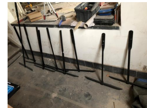
Repareren en schilderen gevelankers
