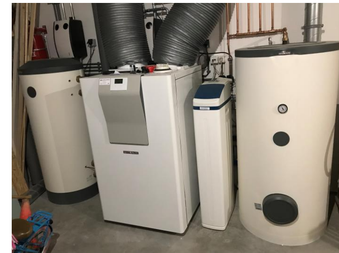
Nieuwe lucht-water warmtepomp installatie op vloering
