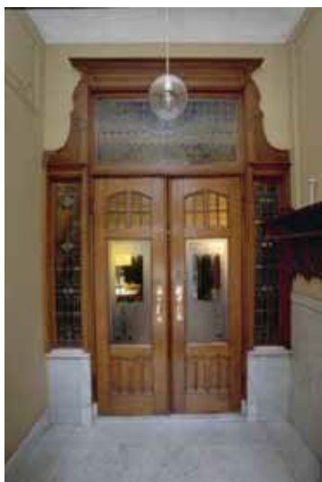
foto 7 deuren B 6.0 door dhr.Berkers
