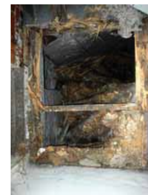
8. Trapopening naar kelder
