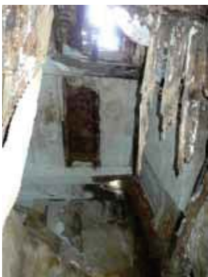
6. Vloer van 1 ste en voorgevel
