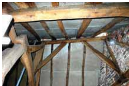
4. Spant 2 en 3 met metselwerkvulling
