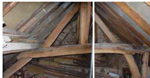
2. Spant 2 met opgehoogd worm
