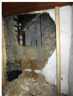
4. Opening kelder en PS30
