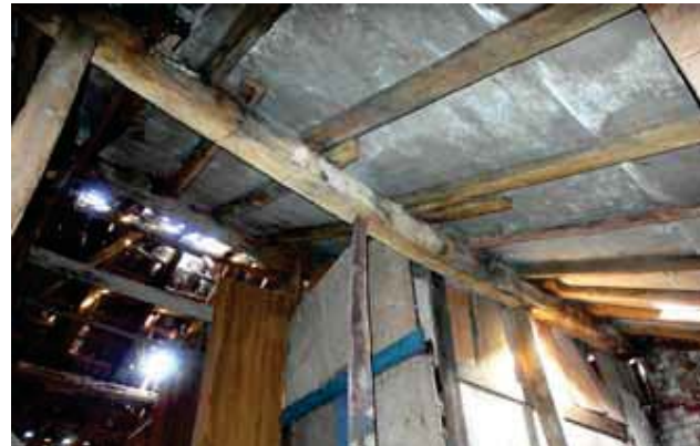
5. Zolderverdieping PS28 staand onder verlegging van dak
