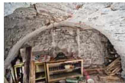
3. Kelderwand richting PS28 ©V.H.
