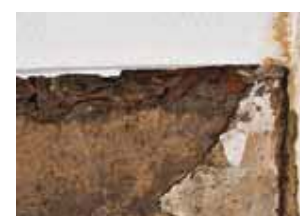
13. dakpannen en puin vulling
