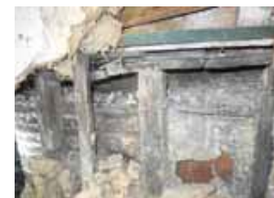
12. hout, steen en puinvulling
