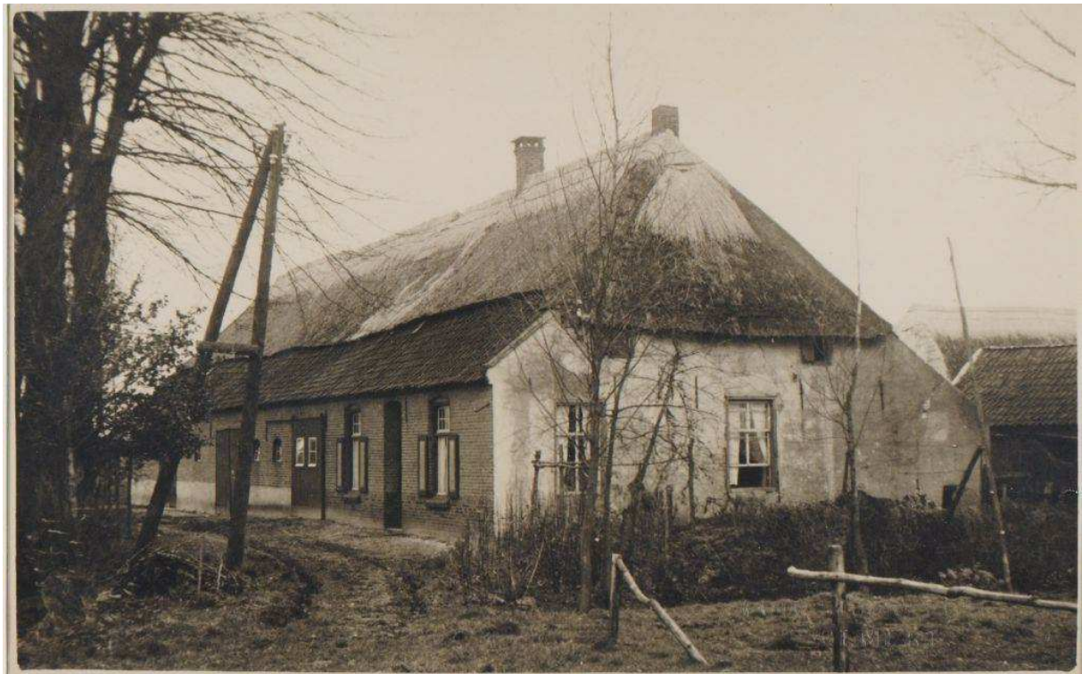
Foto uit 1948. De gevels van het woongedeelte zijn gecementeerd en de indeling van de ramen is gewijzigd van vijftien-ruits naar vier-ruits. Een opkamerraampje rechts is weggewerkt. De luiken in de lange gevel zijn in twee kleuren geschilderd, maar hebben niet de indeling van de Duitse Orde.
