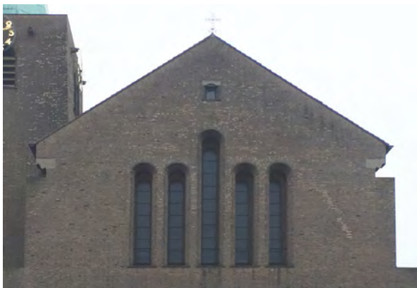
voorgevel St.-Jozefkerk Weert
