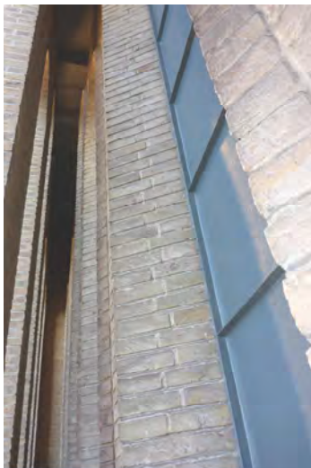
Detail voorgevel St.-Jozefkerk
