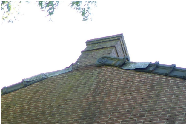
12. Linkerzijgevel: bij schoorsteen windveerpan voor ondereind
