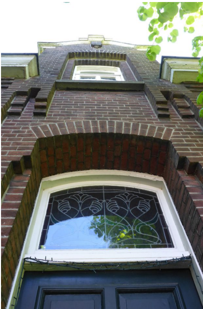
9. Glas in lood raam voordeur, topgevel
