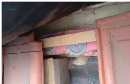
7. Dakschoor doorgezaagd voor nieuwe dakplaat Bron: Nico de Bont / TBI
