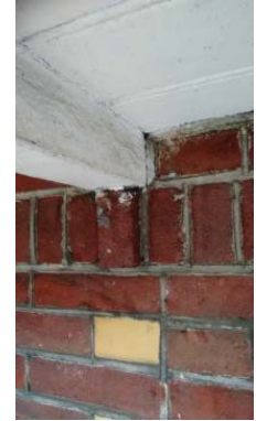
6. Uitkraaghout liggend op uitstekende steen van rollaag. Bron: Nico de Bont / TBI
