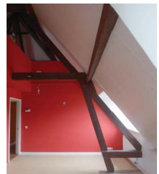
10. Kapsant staande op zoldervloer
