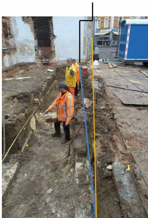
32. Verlopende voorgevellijn 2016 (IDEN2012).
