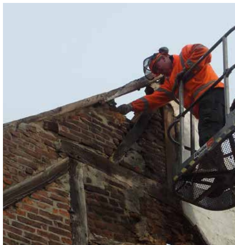
20. Demontage van de vakwerkgevel 2016 (IDEN2012).
